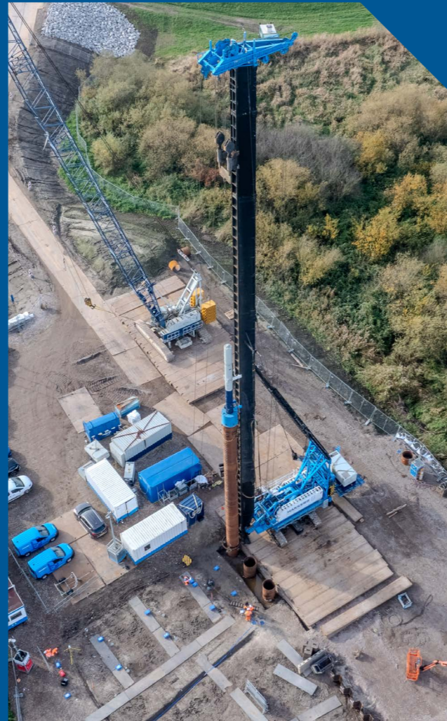
Foto: Heiproef A27, Merwedebrug
